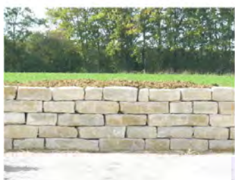
Ouvrages en blocs plus massifs, assemblage en pierre sèche
