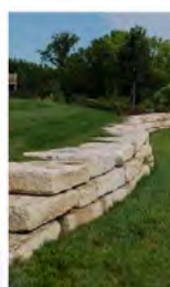
Ouvrages en blocs plus massifs, assemblage en pierre sèche
